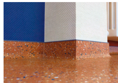
■ Abb. 3: Wandhochzüge über Hohlkehleprofilen erleichtern die Reinigung
